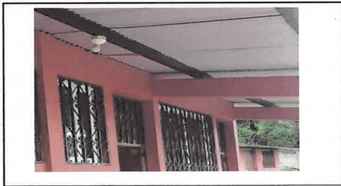
Foto 5: Cambio de instalación eléctrica
