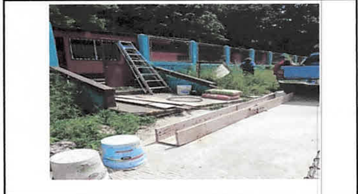
Foto 4: Mantenimiento de terraza y mezlón de baños.
